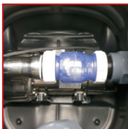
Valvola di ritegno e pompa di scarico
