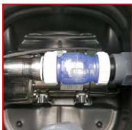
Rückschlagventil RSK und Schmutzwasserpumpe
